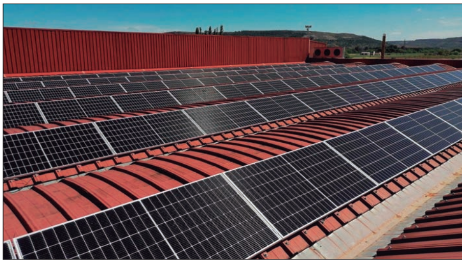
Instalación solar fotovoltaica de autoconsumo en Bodega Pinnafidelis de Cocope en Peñafiel (Valladolid), ejecutadas por Artico.
