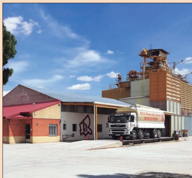
Instalaciones de Tierra de Arévalo en Aldeaseca (Ávila).
