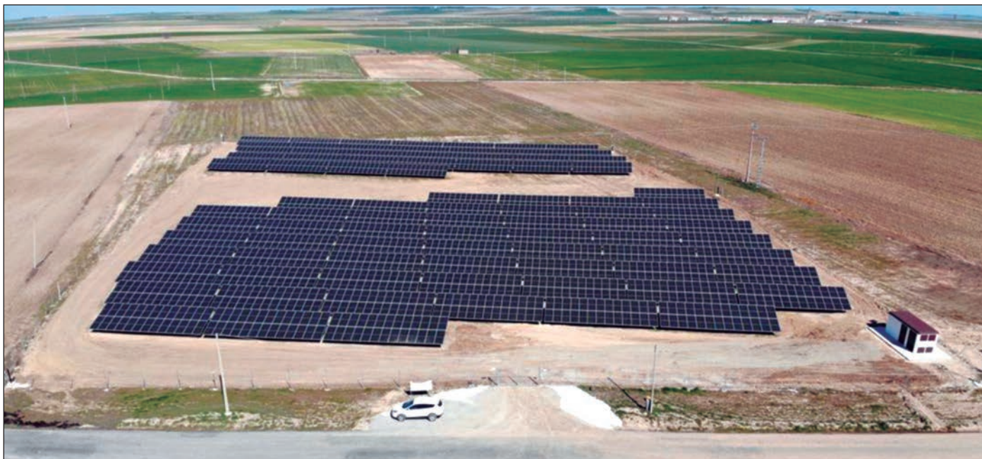
Instalación fotovoltaica de la cooperativa abulense Colina de la Moraña.
