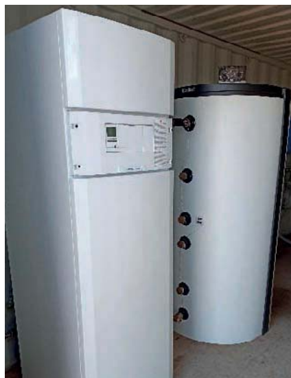
Foto 3. Instalación geotérmica en una granja de la comarca de Monegros.
