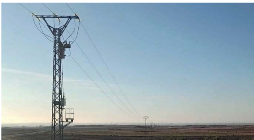
Foto 1. Línea eléctrica en La Almolda (Zaragoza).
