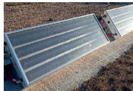
Foto 4. Captadores termosolares planos en una granja de la comarca de Monegros.
