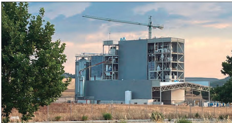
Obras en la futura fábrica de copos, harina y salvado de avena que Agropal construye en Magaz de Pisuerga (Palencia).
