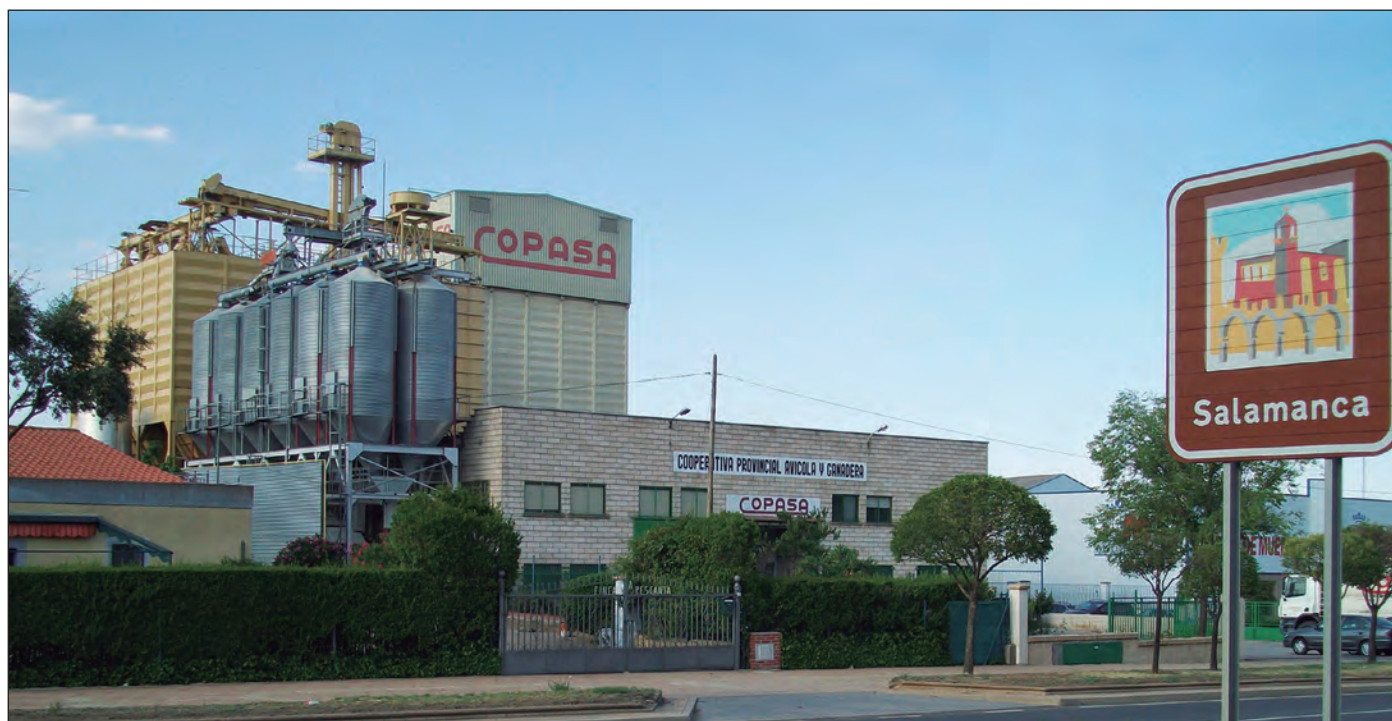
Instalaciones de Copasa en Salamanca.
